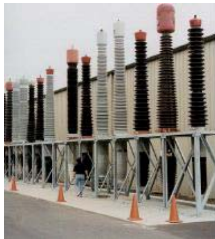
شکل ۱۲-۵ مه‌ار بندی تجهیزات یدکی در انبار
