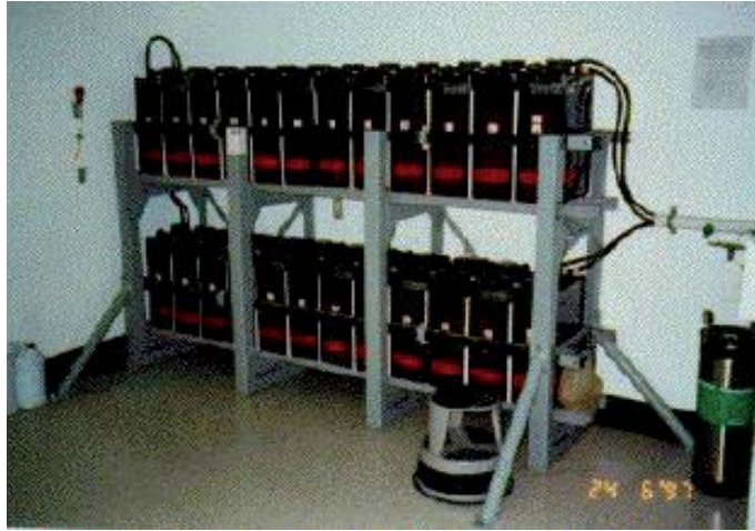
شکل ۱۰-۵ مه‌ار بندی قفسه باتری‌ها جهت کنترل واژگونی
