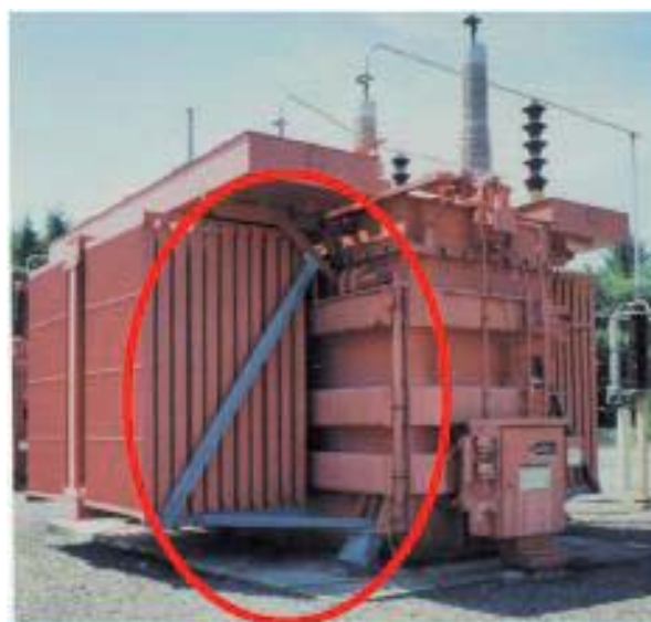
شکل ۵-۵ تقویت مهار بندی رادیاتور ترانس
