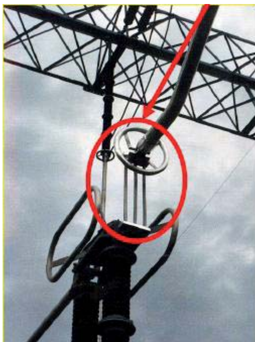
شکل ۸-۵ تعبیه سوئیچ قطع برای کنترل عملکرد تجهیزات
